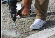
コンクリート面に22mm径程度の穴を深さ90mmまで掘ります。
