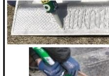
本体・接地面・ボルトに接着材を塗布、穴に接着剤を注入します。
