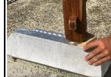
本体を取付ます。はみ出た接着材は乾く前に拭き取ってください。接着材が完全硬化（約2日間）すれば完成です。
