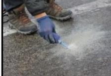
穴の中に残った削りかすをエアブロワーして取除きます。
