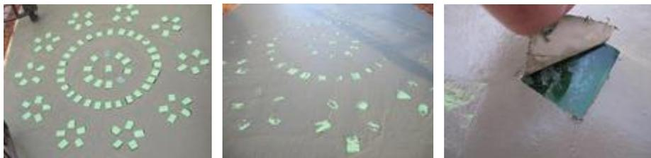
コンクリートの床と同じ高さまで入ったら、コンクリートの床を仕上げていきます。
