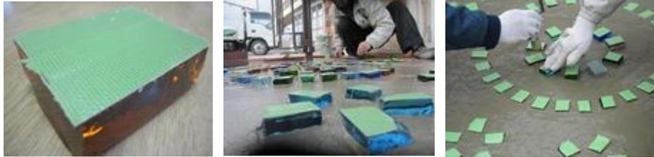
表になる面(より角の丸みが少ない面を上にした方が施工しやすいです)に布テープなどで養生をし、コテで土間を仕上げた時に傷にならないようにします。
