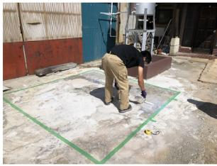
不陸調整材の硬化後、全面に専用のシーラーを刷毛ウールローラーでむらなく塗布してください。
