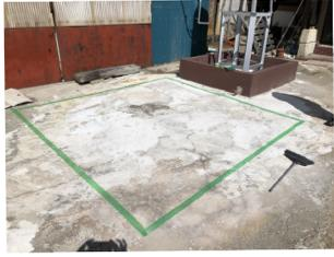
下地のぜい弱層・レイタンス・油分・汚れ等を研磨機または高圧洗浄機を用いて研磨除去して健全なコンクリート面を露出させてください。
