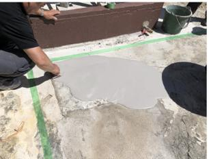
コテ圧をかけて下地に擦り込むように塗り付け後、所定の厚さになるよう塗り付けてください仕上げは金ごて仕上げ、刷毛引き等をおこなってください。
