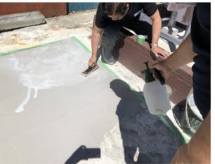
\* コテ押え仕上げは、適度なしまり加減（30分~1時間後）で、適度に水打ちしてからステンレスゴテで平滑に押え仕上げをしてください。
