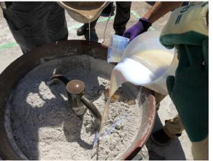
補修モルタル20kgに対し水約3kgと混和液1kgを加え、モルタルミキサーやハンドミキサー等で十分に練り混ぜてください。
