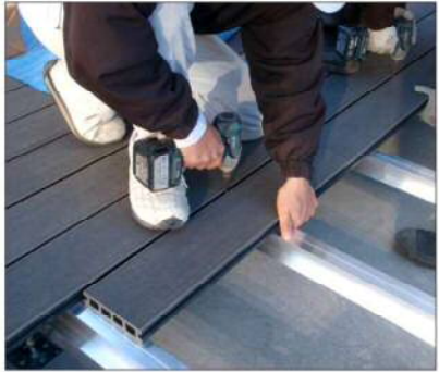
縦目地・横目地とも 5mm 以上確保 (目安として冬期は目地を大きめにして下さい)
