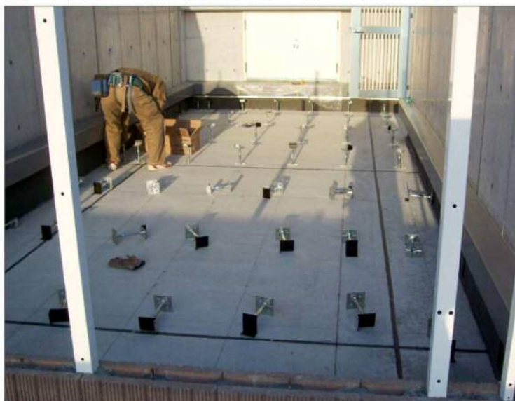
束柱の組み立て
