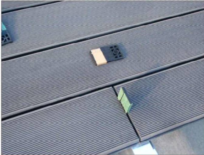
縦目地・横目地とも 5mm 以上確保 (目安として冬期は目地を大きめにして下さい)
