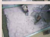
モルタル、コンクリート下地に水湿しをしてから下塗り材を約1mm厚でコテ塗ります。
