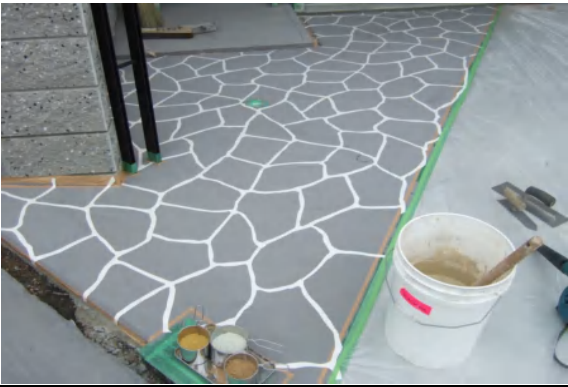
④ ステンシル設置 ⑤ モデファイヤー希釈液を軽く塗布又は霧吹きで塗布
