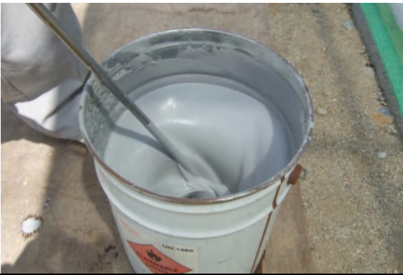
③ ①カラーパウダーと水を混練しベースコートを作成
