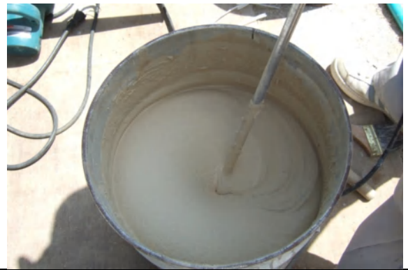
⑥ ①カラーパウダーと水を混練してトップコートを作成し コテでテクスチャーをつけながらトップコートを塗布
