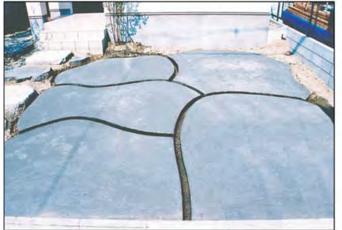
⑧ スリットライナーの抜き取り完了。 (幅が8cmに揃いスリッド曲線が美しい)
