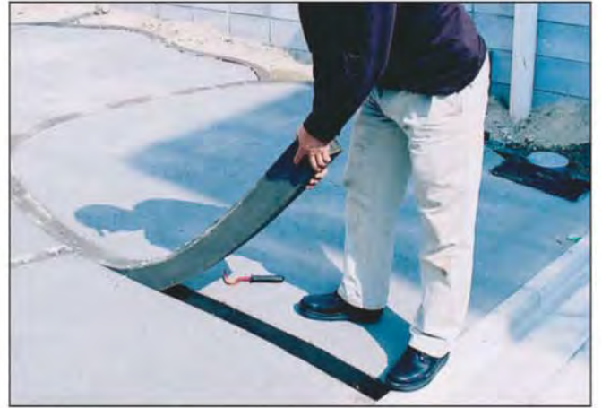
↓ ⑦ スリットライナーの抜き取り。
