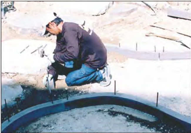
↓ ② 10mmの異形鉄筋棒でスリットライナーを設置。 (一人で簡単に設置出来る)
