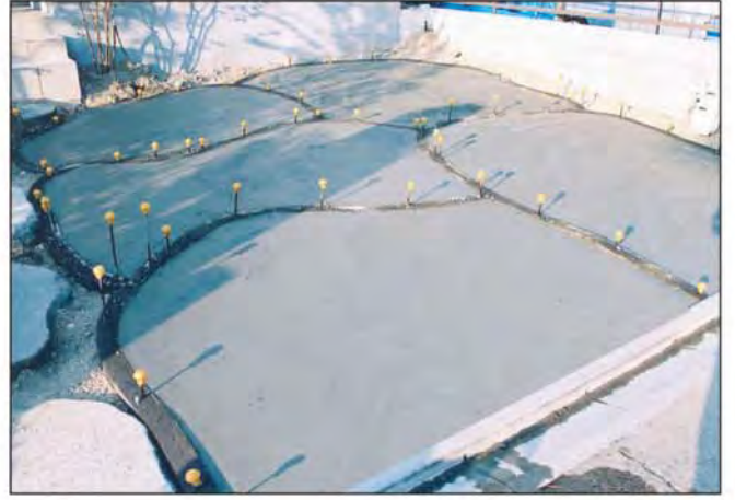
↓ ⑤ 生コン打設完了。
