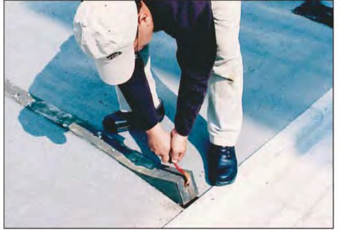
↓ ⑥ スリットライナーの頭出しが簡単に出来る。
