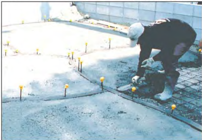
↓ ④ 生コン打設。(スリットライナーの天端がレベリングになる)
