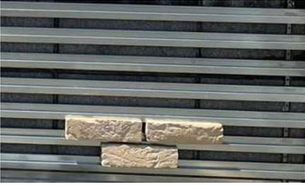
石材、レンガの上部にある溝に合わせて金属レールにはめ込みます。
