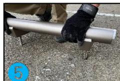
⑤ ボルトが穴底に到達した際、接地面と本体に隙間ができないかを確認します。
