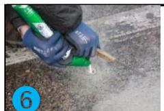
⑥ 本体接地面・ボルトに接着材を塗布、穴に接着剤を注入します。
