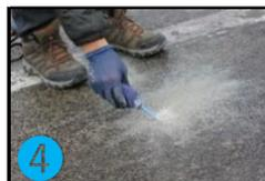
④ 穴の中に残った削りかすをエアブローして取除きます。
