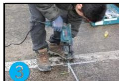
③ コンクリート面に22mm径程度の穴を深さ125mmまで掘ります。
